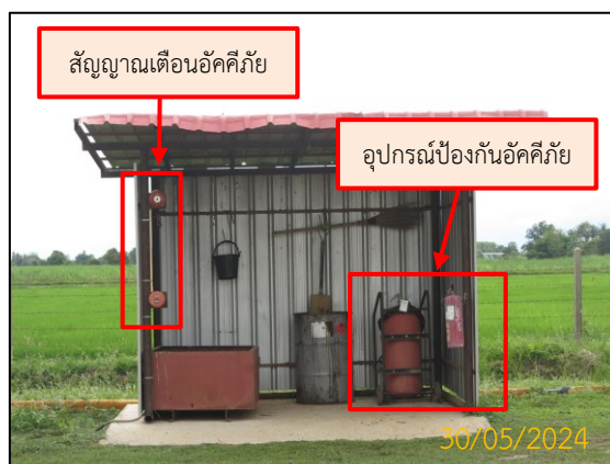
ภาพที่ 2.3-5 อุปกรณ์ป้องกันอัคคีภัย และสัญญาณเตือนอัคคีภัย
