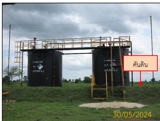
ภาพที่ 2.3-3 ถังกักเก็บน้ำมันดิบที่มีคันดินล้อมรอบ
