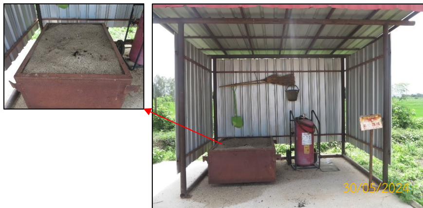
ภาพที่ 2.2-7 อุปกรณ์ดูดซับและทำความสะอาดคราบน้ำมัน
