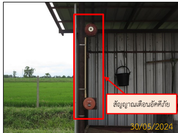
ภาพที่ 2.2-23 อุปกรณ์ป้องกันอัคคีภัย และสัญญาณเตือนอัคคีภัย
