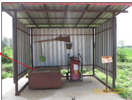
ภาพที่ 2.3-2 อุปกรณ์ดูดซับและทำความสะอาดคราบน้ำมัน
