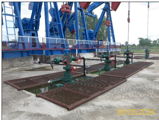
ภาพที่ 2.2-10 อุปกรณ์ชุดวาล์วปากหลุม (Well Head Unit)
