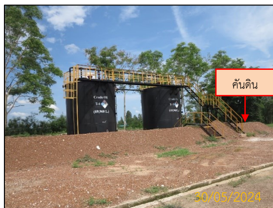
ภาพที่ 2.3-3 ถังกักเก็บน้ำมันดิบที่มีคันดินล้อมรอบ
